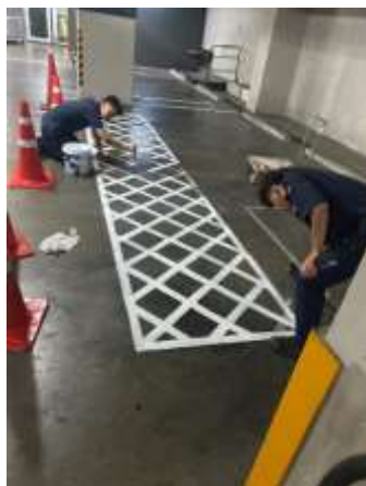
รูปที่ 50 เจ้าหน้าที่ซ่อมแซมสัญญาณจราจรบนพื้นทาง
